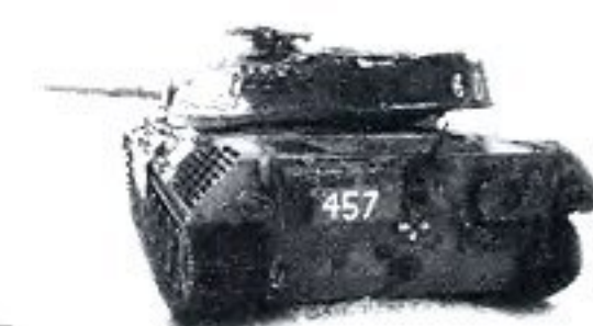
Ein gezogener Leopard 1A5 Turm in einem speziellen Lagerungsgestell. Diese Gestelle waren im Instandsetzungszug der Panzerbataillone in der Regel nicht vorhanden. Beachte die montierten Poller zum Turmziehen. Rechts steht ein Bergepanzer M 88 A1 GE. A lifted Leopard 1A5 turret in the depot frame mounting. These frames were not part of the standard equipment set of the maintenance platoon of a tank battalion. Note the fixed lifting eye for lifting the turret. On the right a M 88 A1 GE Armoured Recovery Vehicle (ARV). (GBO)
